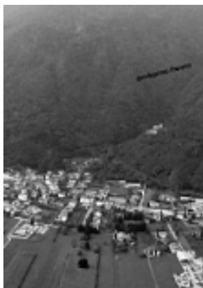
Lodrone e il versante interessato alla frana
